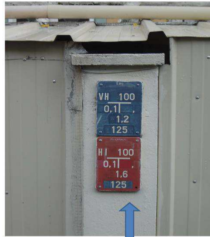
Hydrant de 100mm ou bouche d'incendie avec R.V.
